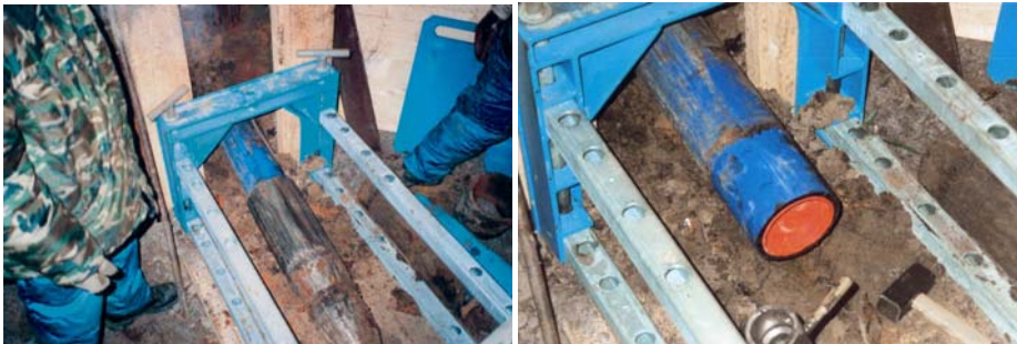
Links: Ankunft des Rohres im Zielschacht Rechts: SIMONA® SPC-Schutzmantelrohr im Zielschacht
