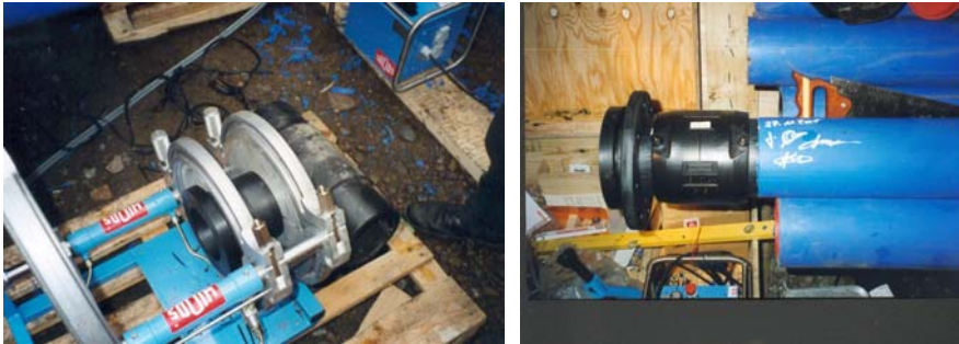
Links: Vorbereitung von Formstücken für die Hausanschlüsse mittels Heizelementstumpfschweißen. Rechts: Vorbereitung von Flanschanschlüssen mittels Heizwendelschweißung.
