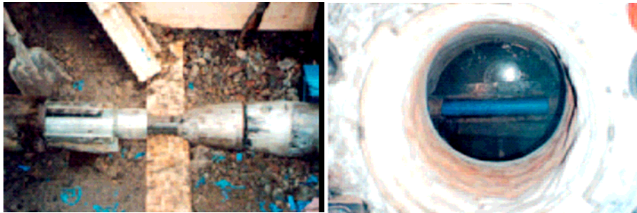
Links: Berstkopf mit Schneid- und Verdrängungseinheit beim Einbringen in die zu berstende Stahlleitung. Rechts: Optische Kontrolle in einem durchfahrenden Zwischenschacht in der zu sanierenden Haltung.
